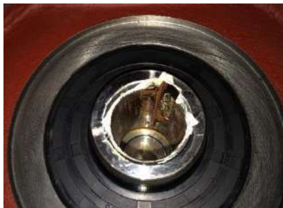
Рис 7: Участки коррозии на впадом валу редуктора
